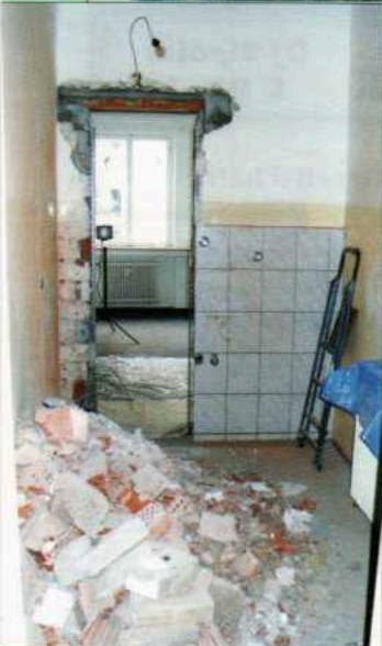
Toilette (oben) und Küche vor bzw. während der Renovierungsarbeiten.
